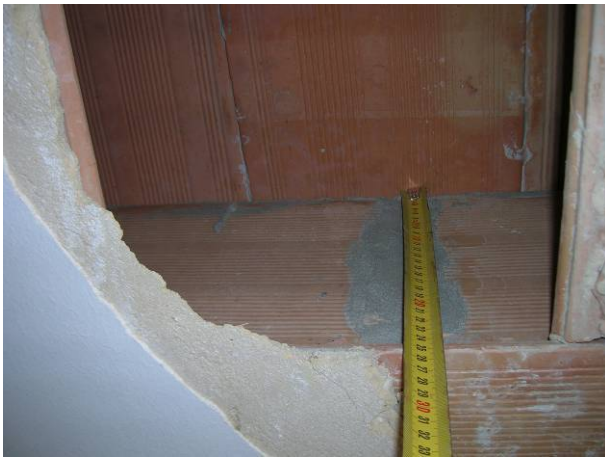
Figura 1-4 Foto del solaio reale e ricostruzione dello schema costruttivo.
