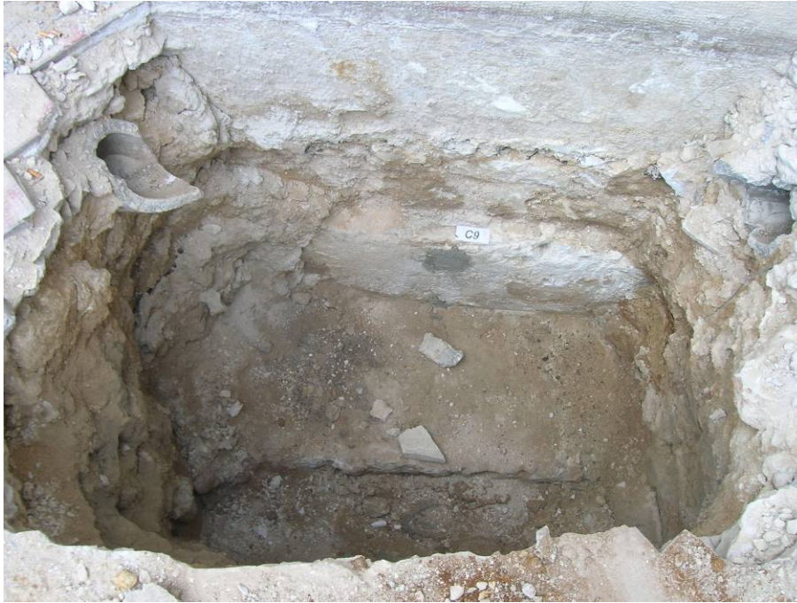
Figura 1-2 Pozzetto di fondazione
